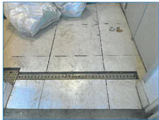
ระบบรวบรวมน้ำเสียหลังล้างห้องพักรวม
